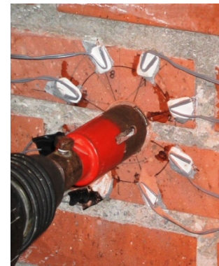
Ensayo de "Hole Drilling" en muros de fábrica: conocer el estado tensional a partir de las medidas de deformaciones originadas al practicar un orificio cilíndrico en la pared. (Colaboración con Prof. Sánchez Beitia)
