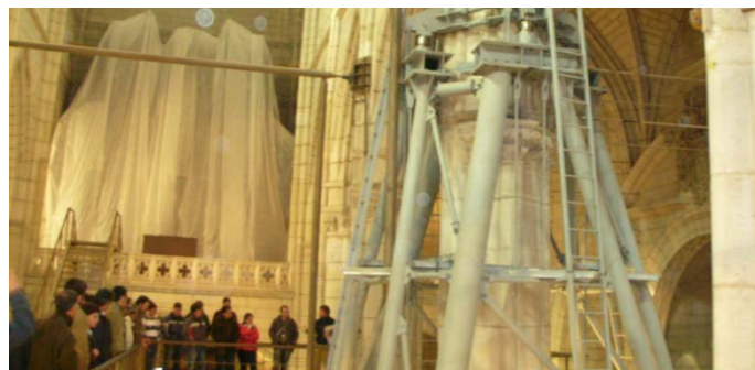
Visita de los alumnos del Máster a las obras de rehabilitación de la Catedral de Santa María en Vitoria
