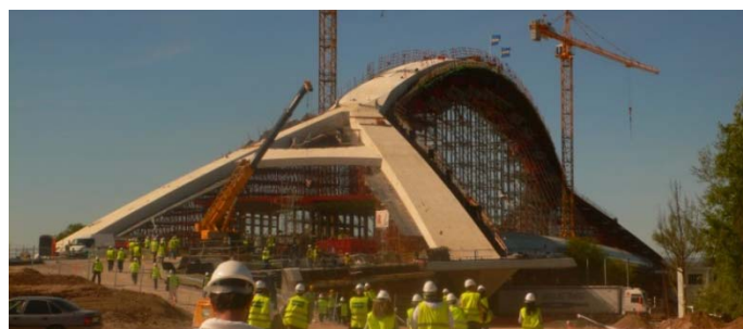
Puente del Tercer Milenio: Visita del Máster a EXPO 2008
